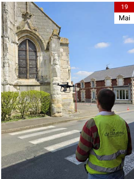
Survol de l'église Sainte Marie-Madeleine par un drone afin de réaliser un diagnostic sur l'état de l'édifice et de programmer les travaux à réaliser en priorité
