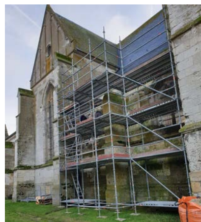
Début des travaux de remplacement des pierres abîmées par le temps à l'église Saint Martin
